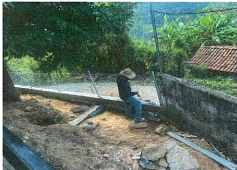
Foto 1: Mejoramiento de muro de contencion para resguardar la integridad fisica de los niños y niñas del establecimiento educativo.
