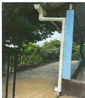
Foto 5. Mejoramiento de bajada de agua pluvial para asi poder dar un mejor uso al agua en la jardinizacion del establecimiento educativo.
