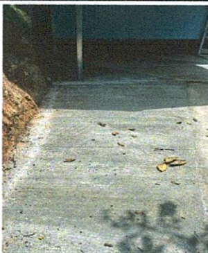
Foto 1: Mejoramiento de torta de cemento para que los niños y niñas tengan una superficie de piso evitando la tierra y el polvo.
