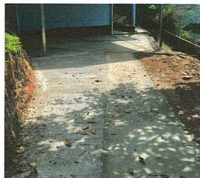
Foto 2: Mejoramiento de torta de cemento para que los niños y niñas tengan una superficie de piso evitando la tierra y el polvo.
