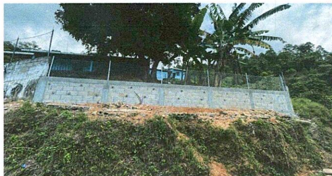
Foto 2: Mejoramiento de muro de contencion para resguardar la integridad fisica de los niños y niñas del establecimiento educativo.
