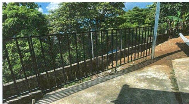
Foto 4: mejoramiento del cerco perimetral colocando baranda metalica para resguardar la integridad fisica de los niños y niñas de la etapa 4.
